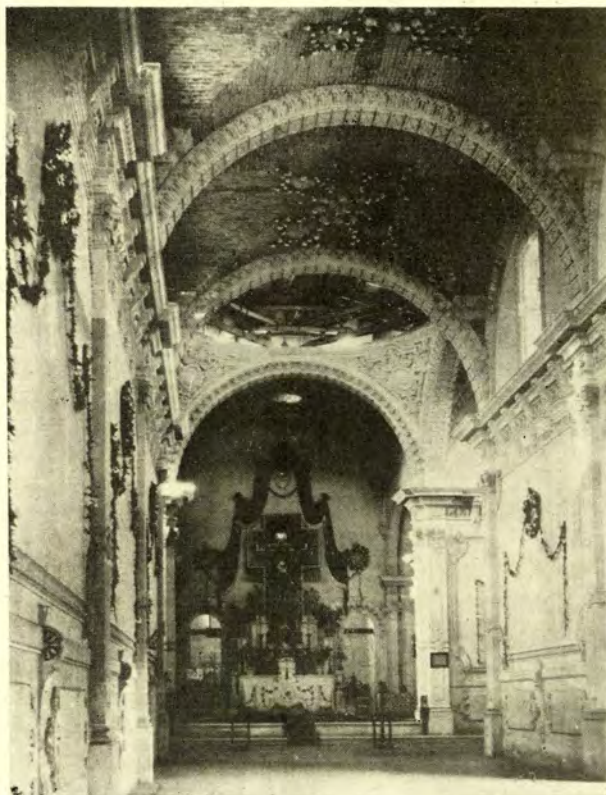
Interior del Santuario en construcción, al Señor de los Rayos, en Temastlán.
