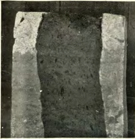
13. Doorsnede van spleet met asfalt (1/20 ×) (Kaboengka) (Foto Mijabouw Mij. Boeton)
