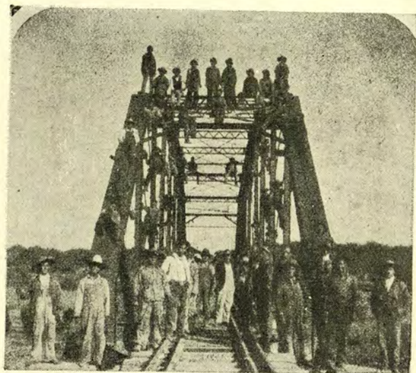
Grupo de operarios que pintaron el puente de Río Verde, S. L. P., bajo las órdenes de los contratistas Dublán y Schwabe, División Cárdenas.
