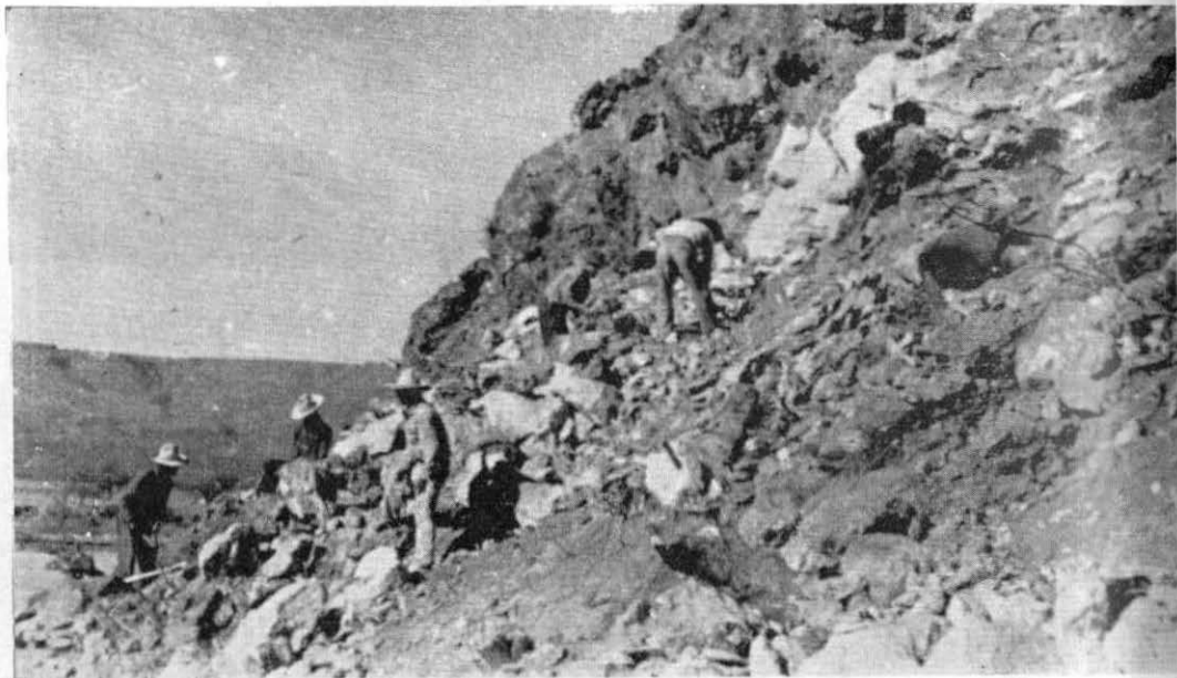
Excavaciones para formar el tajo de desviación definitivo de El Palmito.
