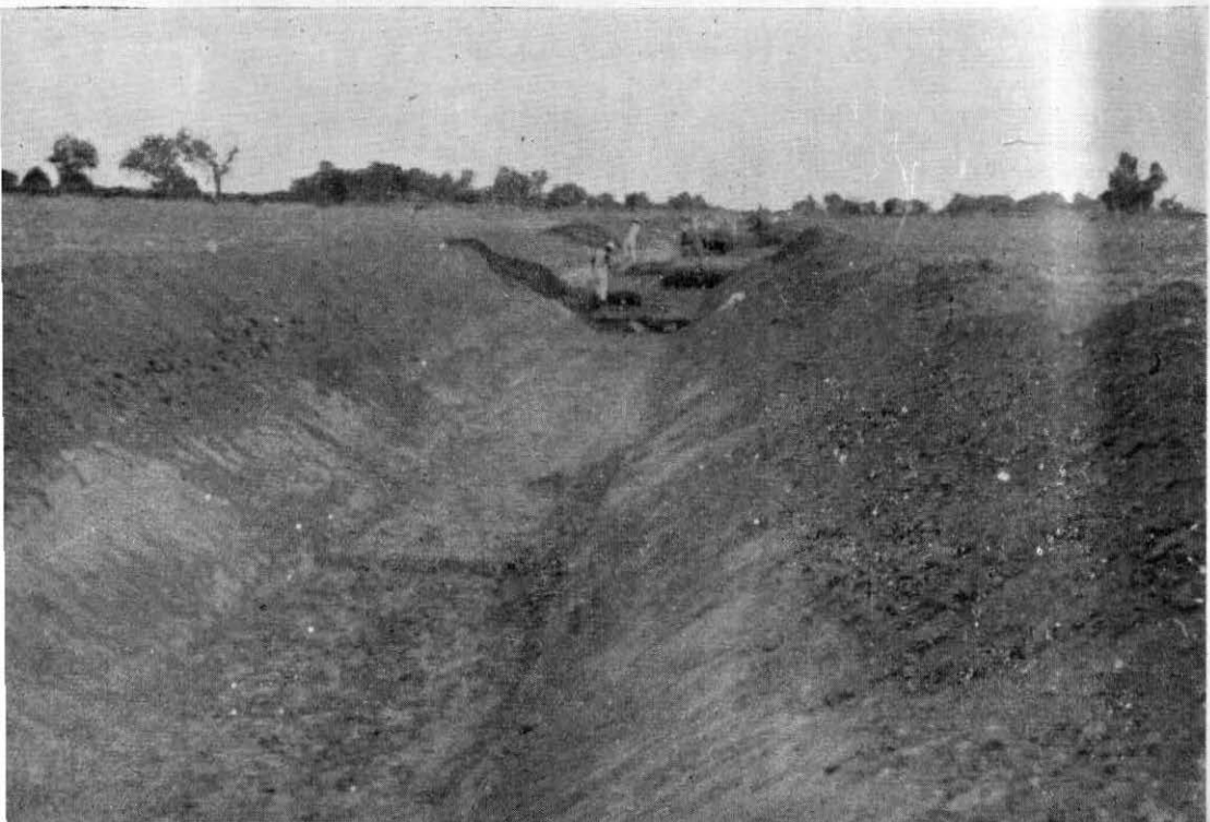
Construcción de los canales “Marcos Carrillo” y Bataconca, destinados a hacer más productivas las tierras de los yaquis.
