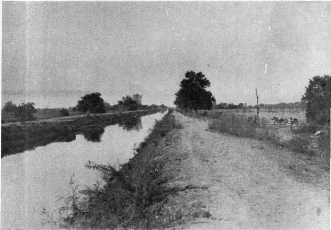
Otro tramo del canal "Rosales", parte importante del Sistema de Riego número 10. Sinaloa.
