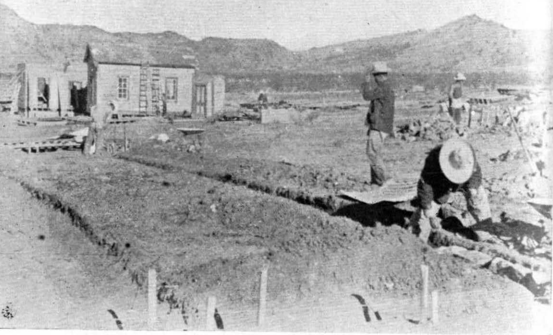
Construcción del campamento de El Palmito.
