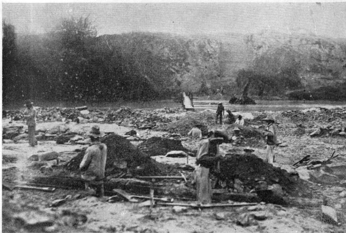
Operarios trabajando en el Río San Juan.
