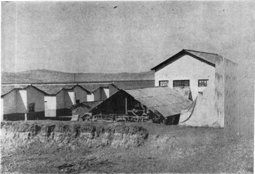
Casa de bombas de San Luis. Sistema Nacional de Riego, número 13.
