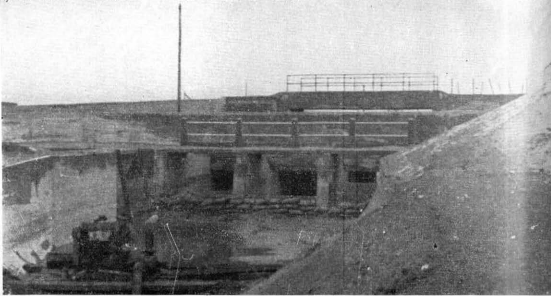
Estructura del puente sobre la Acequia Madre. Sistema Nacional de Riego, número 9. Ciudad Juárez. Chih.
