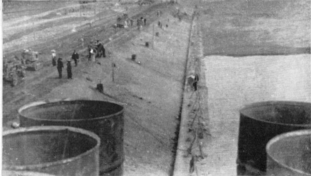
Aspecto interesante de las labores para la terminación de la corona de la presa de Santa Rosa, Zac.
