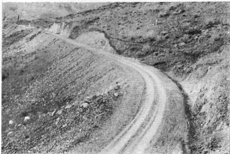
Un aspecto del camino de Bermejillo a El Palmito, construido por la Comisión Nacional de Irrigación.
