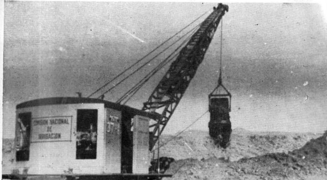
Draga 37-BE, excavando el tajo de derivación provisional, en El Palmito.
