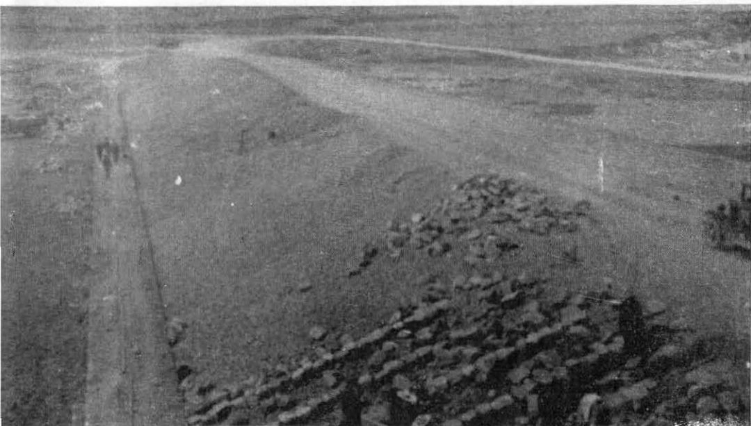
Entroncamiento en el paramento de aguas arriba. Presa de Santa Rosa, Zac.
