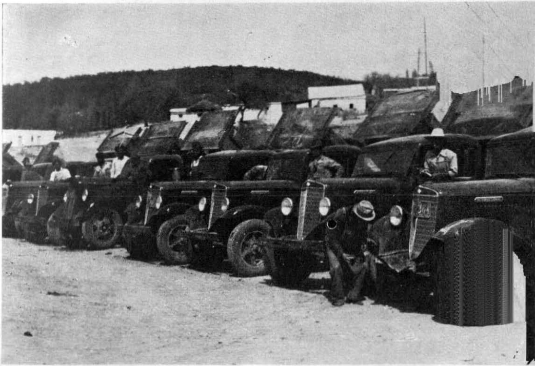
Parte del potente equipo empleado en la construcción de la presa "Alvaro Obregón", de San Luis Potosí, S. L. P.
