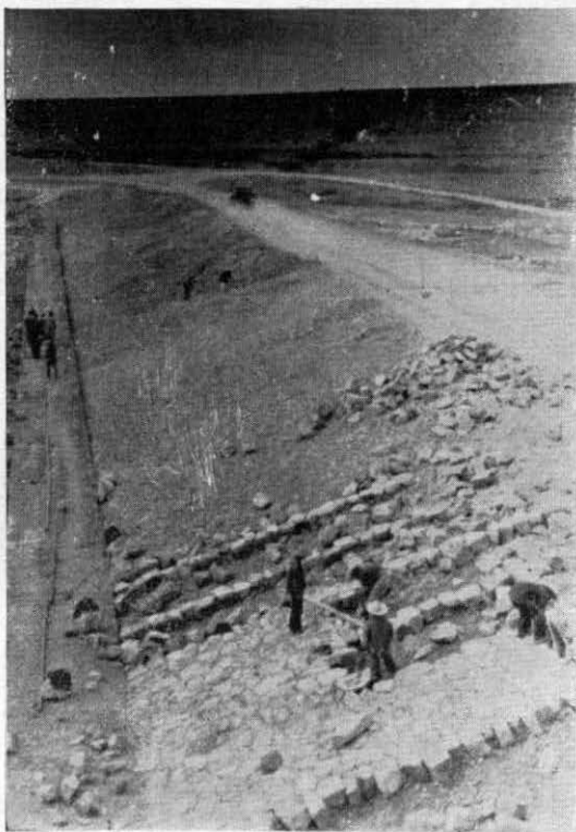
Construcción de la cortina de la presa de Santa Rosa, Zac. Enrocamiento en el paramento de aguas arriba.
