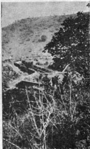
Fot. 4.—Vista de los tanques de almacenamiento de agua en "Los Filtros," Morelia, Mich.
