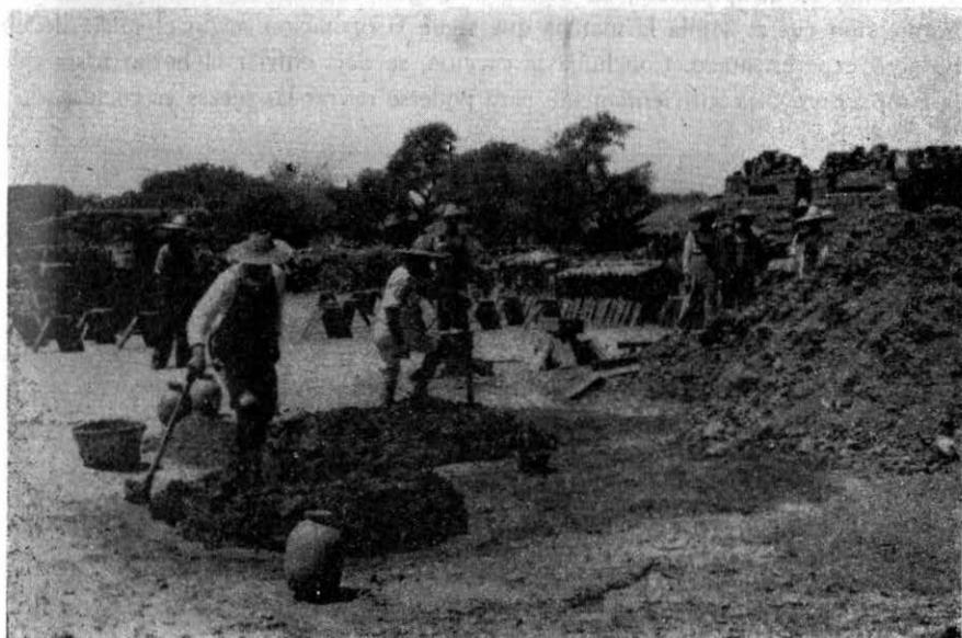
Fotografía número 29.—Amasado de la mezcla de tierras para la elaboración de ladrillos, tejas, etc. Ladrillera cercana a Ixtlán de los Hervores.
