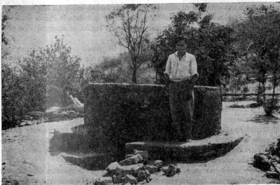
Fotografía número 6.—Horno para fabricar cazuelas y ollas en Zinapécuaro.
