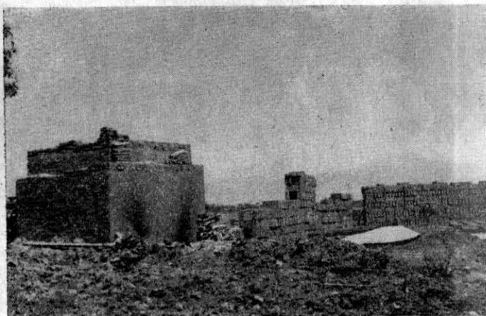
Fotografía número 30.—Fábrica de tabique en Tangancícuaro. A la derecha puede observarse cómo se acomodan los tabiques para que se sequen, antes de ser llevados al horno.
