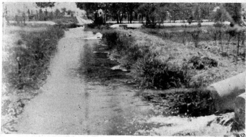
Foto. N° 22.—Canal colector de las aguas de varios pozos artesianos. Hda. de Gogorrón.
