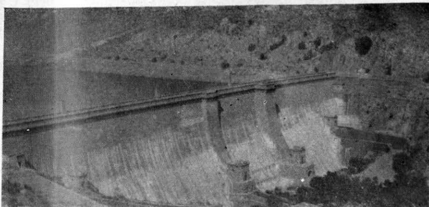
Foto. N° 6.—Presa de San José, San Luis Potosí.
