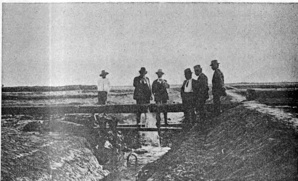
FOT. NUM. 14. Canal de madera que conduce el agua del pozo artesiano del K. 2 del Ferrocarril de las Obras del Lago de Texcoco, a la Zona de Experimentación de la mismas.
