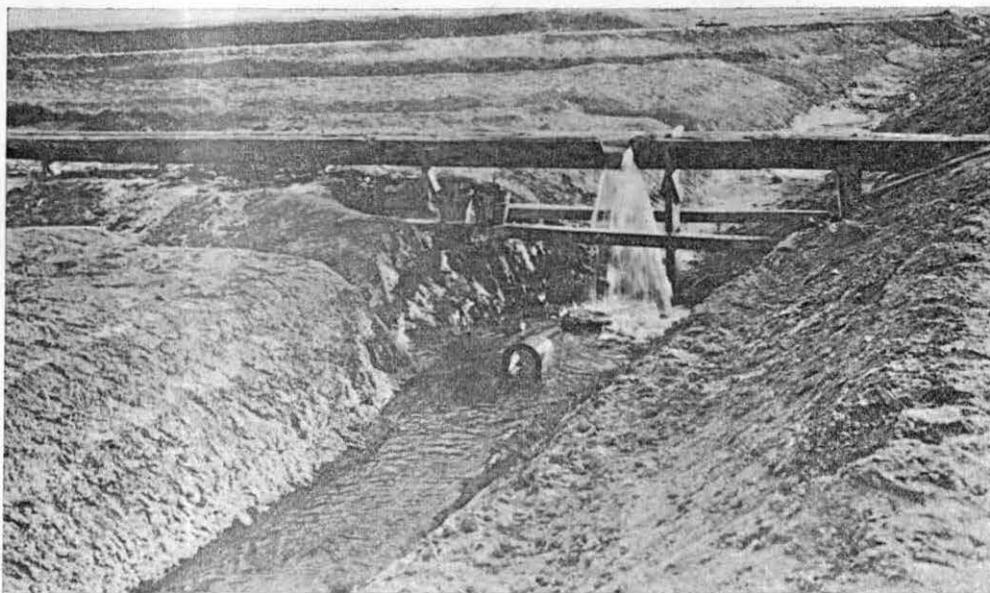
FOT. NUM. 13. Detalle del canal de madera que conduce el agua del pozo artesiano del K 2 del Ferrocarril de las Obras del Lago de Texcoco, a la Zona de Experimentación de las mismas.
