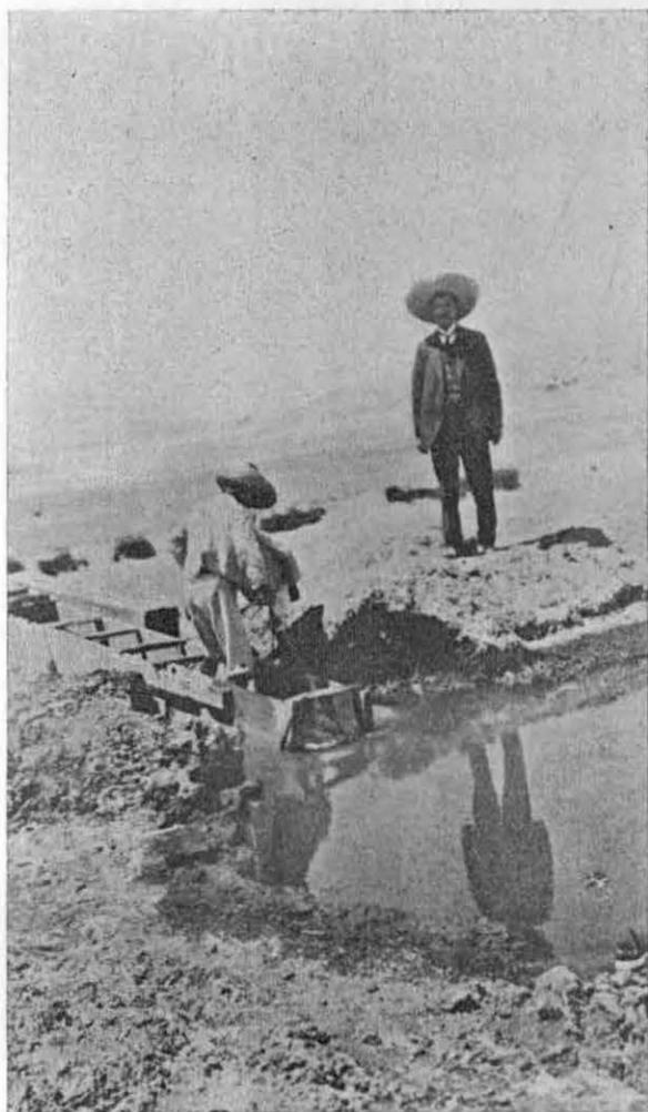
FOT. NUM. 11. Final del movimiento del «bimbalete» o cajón usado en la explotación del tequesquite.
