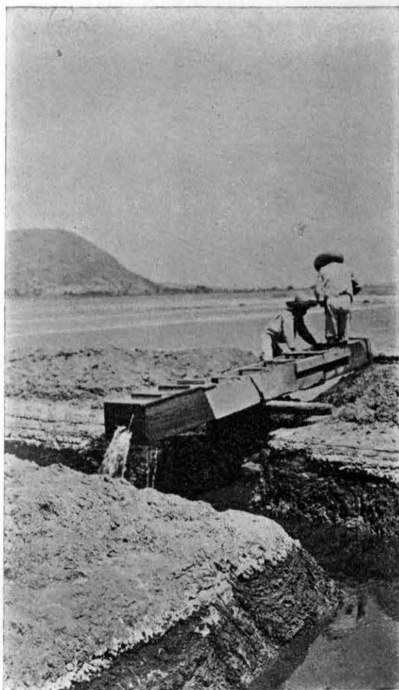
FOT. NUM. 10. Desperdicio del agua durante el «movimiento del bimbalete,» al vaciarlo en los terrenos para la explotación del tequesquite de Santa Clara Coatitla.
