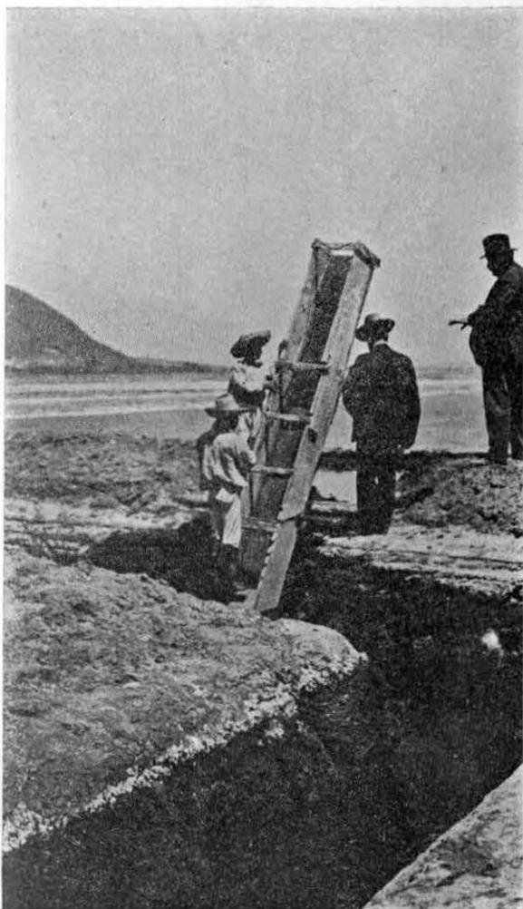
FOT. NUM. 9. Llenando de agua un «bimbalete» en una zanja de riego, para inundar los terrenos en las explotaciones de tequesquite.
