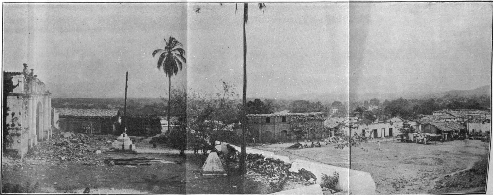
Vista de Ayutla. Los techos están en parte renovados después del temblor
