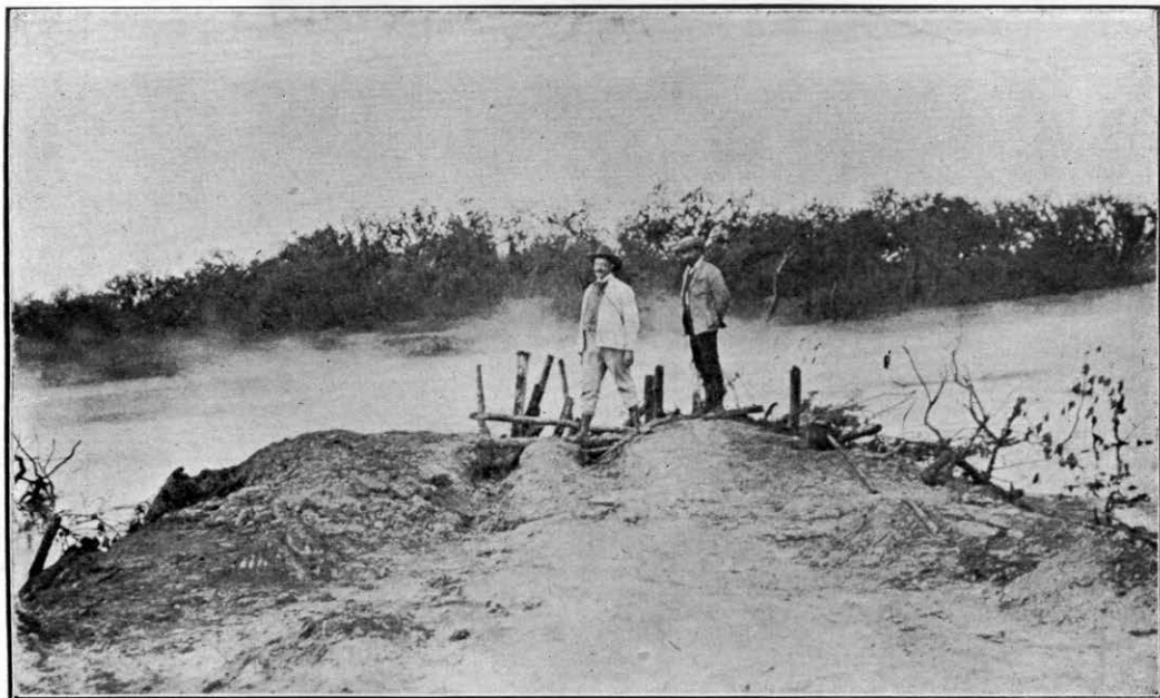
Brecha abierta en el dique anterior. (Fig. núm. 23.)
