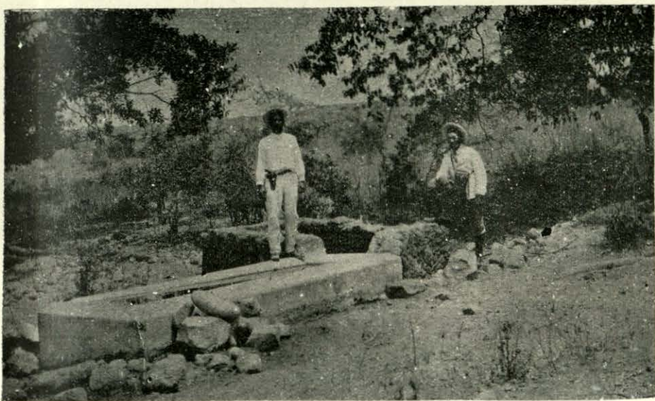
No. 22.—POZO EN PASTORES. ESTADO DE COLIMA.
