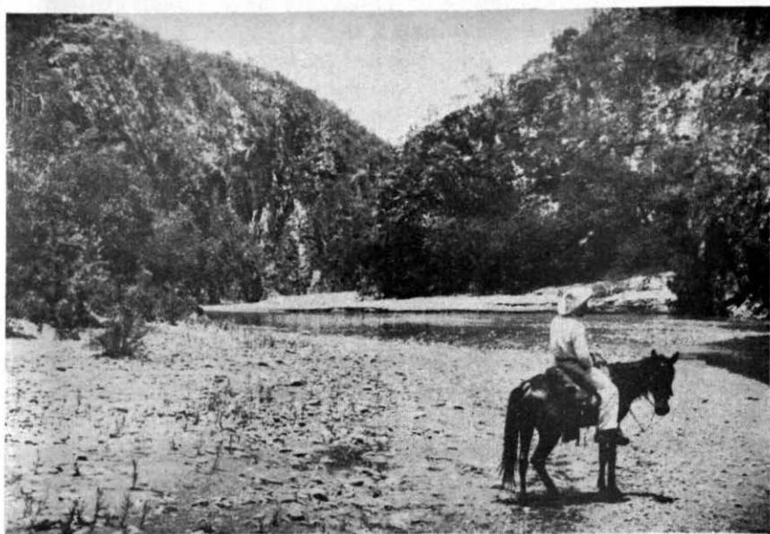
La boquilla inferior vista desde aguas abajo. (Foto N° 6)
