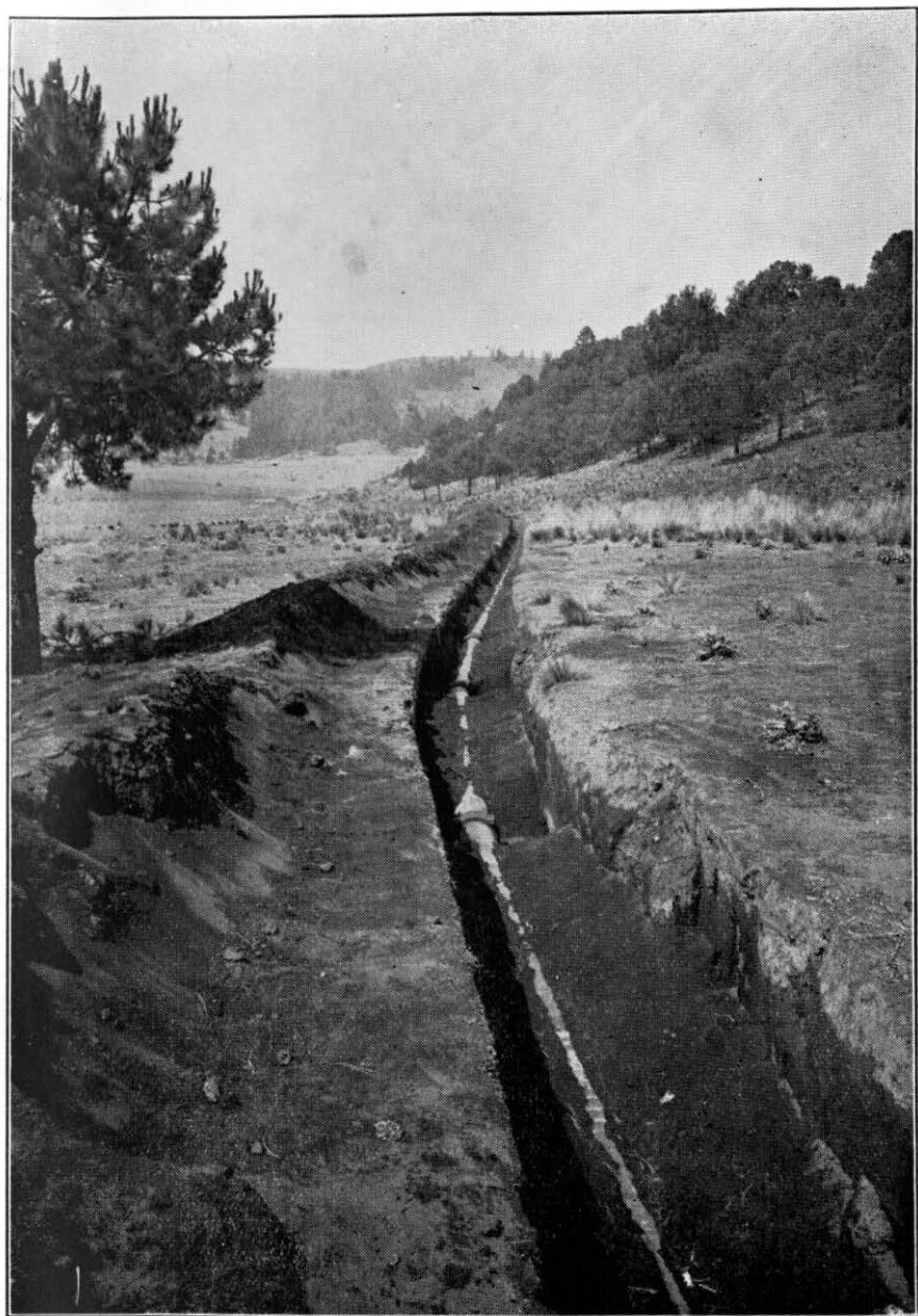
Tubería instalada en cepa, al sur de la población del Ajusco.
