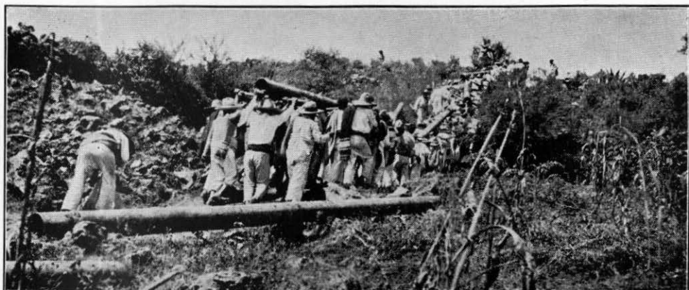
Caravana de transporte de tuberías, por la línea troncal de Milpa Alta.
